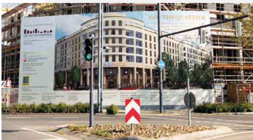
Ebenfalls im Bau: das Goethequartier in Offenbach.
