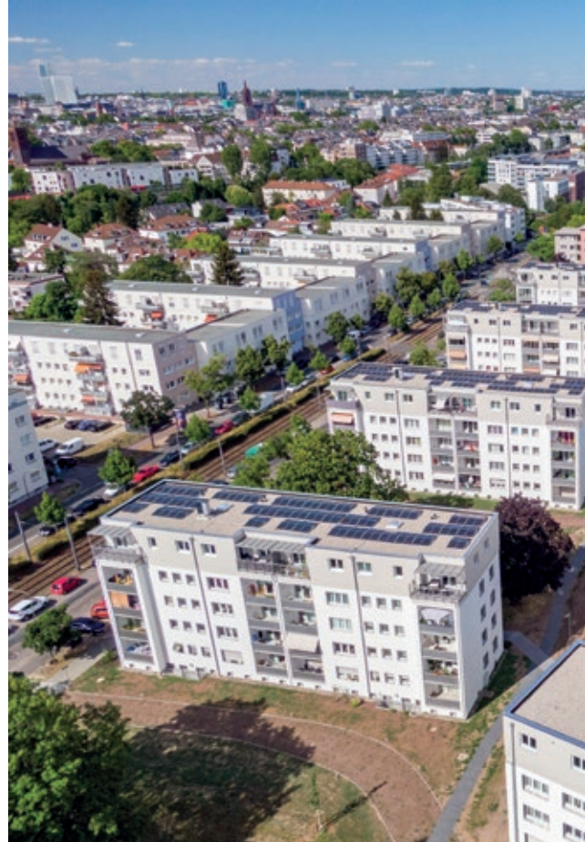
Aufgestockt: In Frankfurt wurde die Fritz-Kissel-Siedlung um 82 Wohnungen erweitert, die Dächer mit Photovoltaik-Anlagen ausgestattet.
